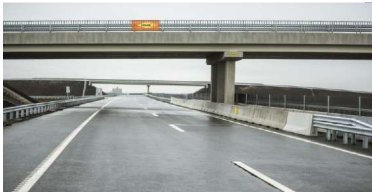
M86 hídszigetelés HÍD-2 rendszerrel
