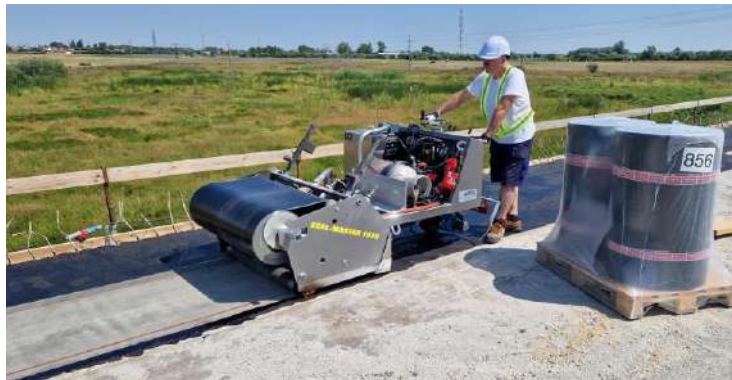
M3 hídszigetelés jumbo terekcsekkel
